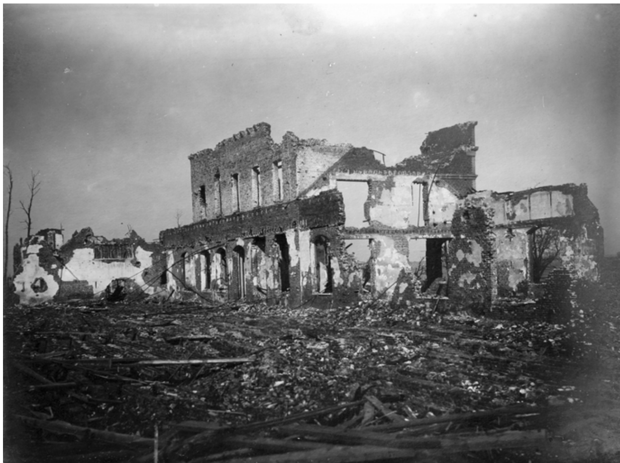
Façade postérieure des bureaux en ruine, vers 1919 (AD Aisne).
