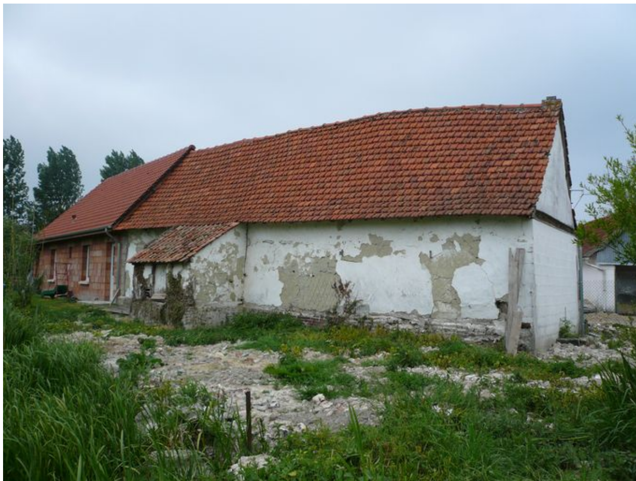
Vue postérieure avec aire de battage saillante.
