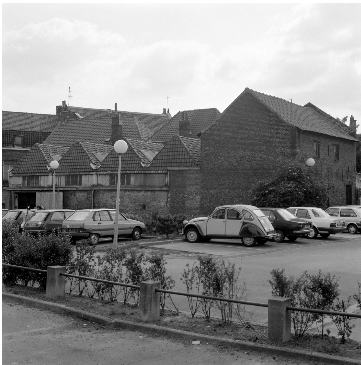
Atelier de fabrication et magasins industriels.
