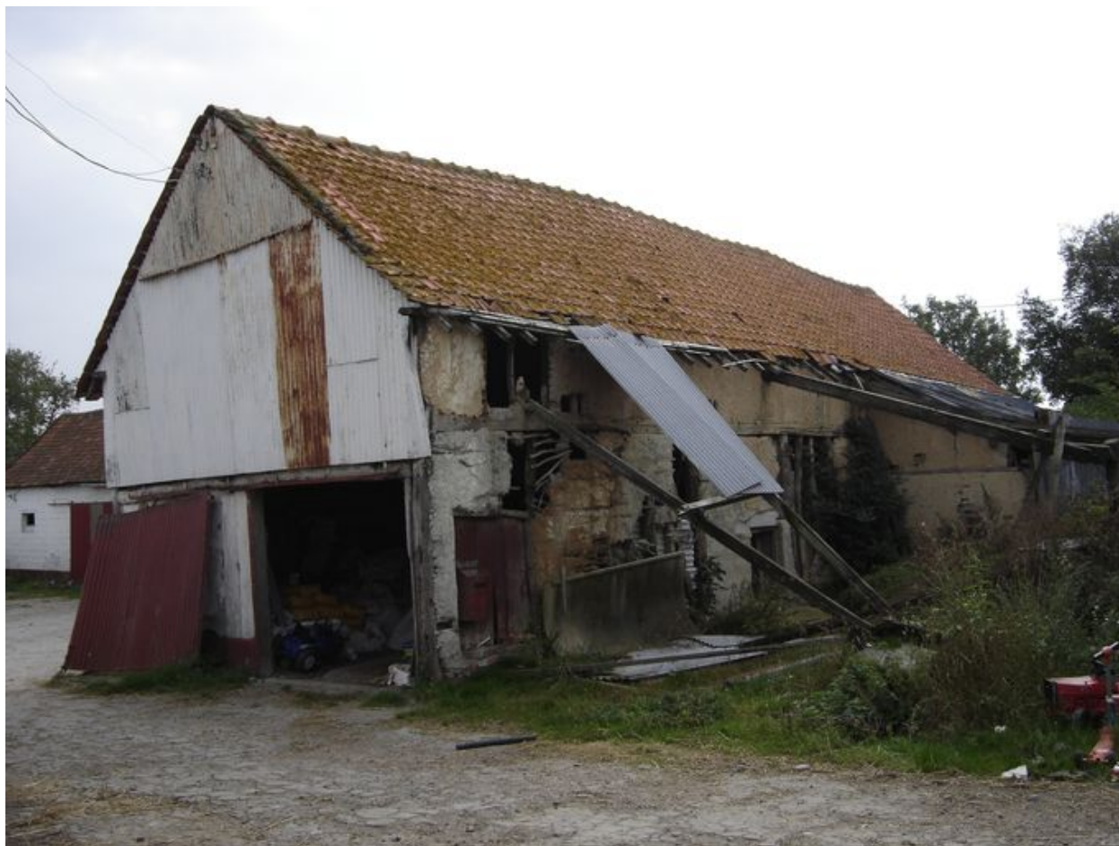
Vue postérieure de la grange.
