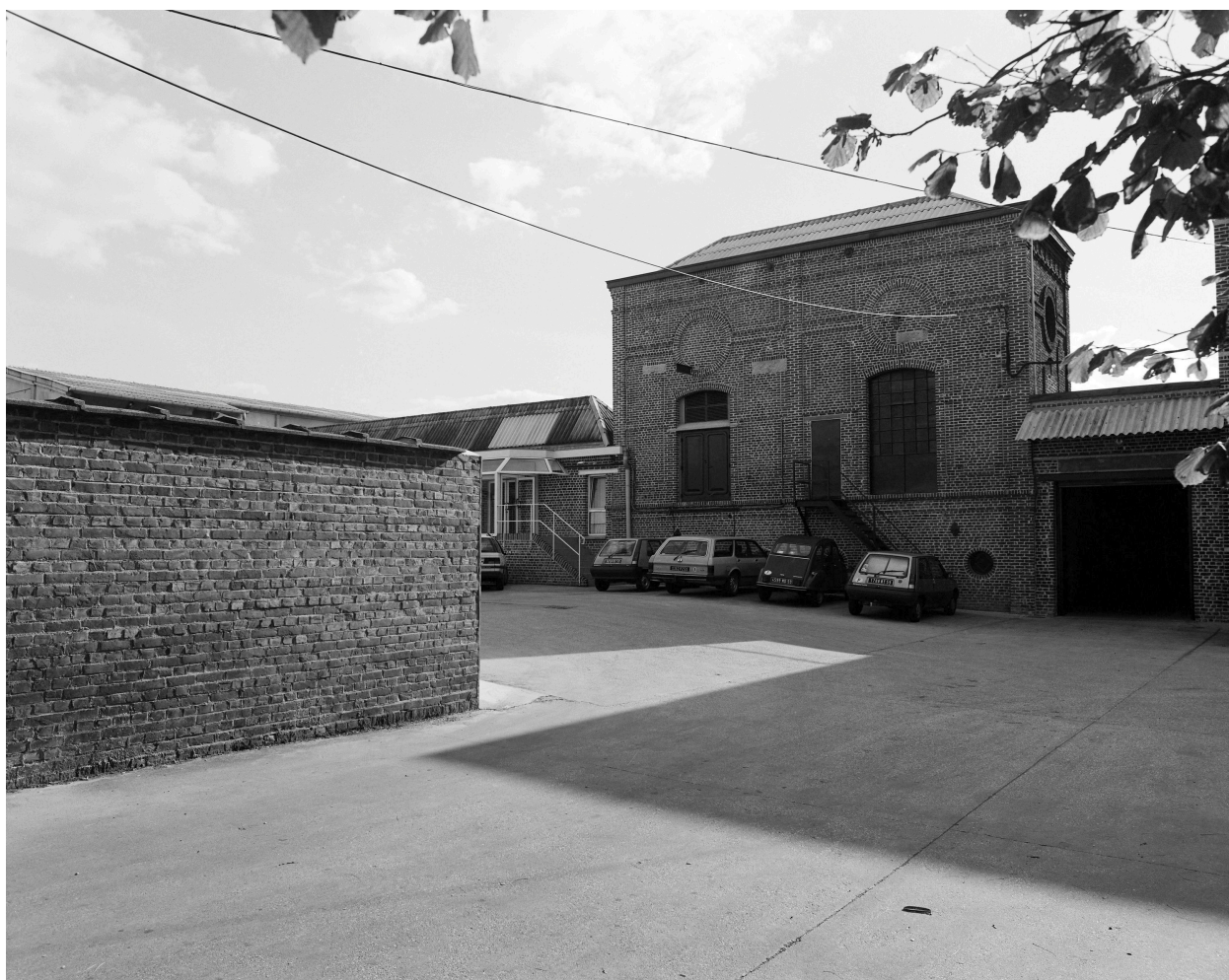
Salle des machines, élévation sur cour.
