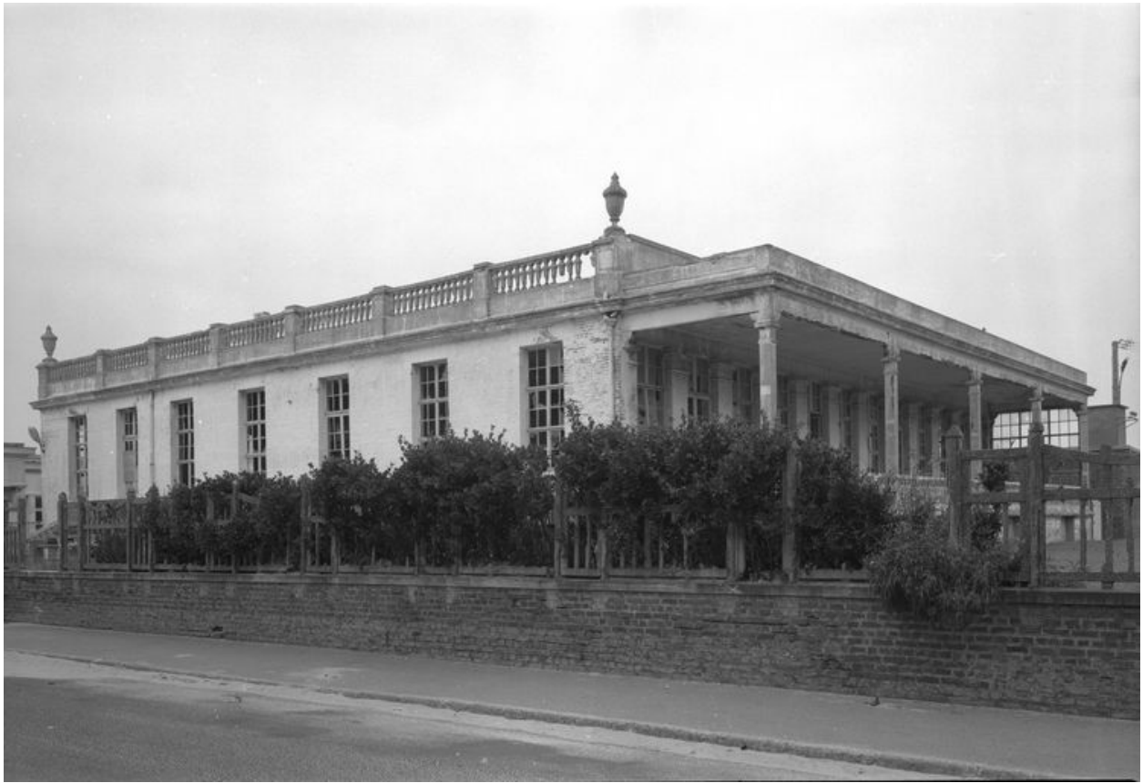
Élévation antérieure précédée de son solarium et élévation latérale gauche, vue d'ensemble.
