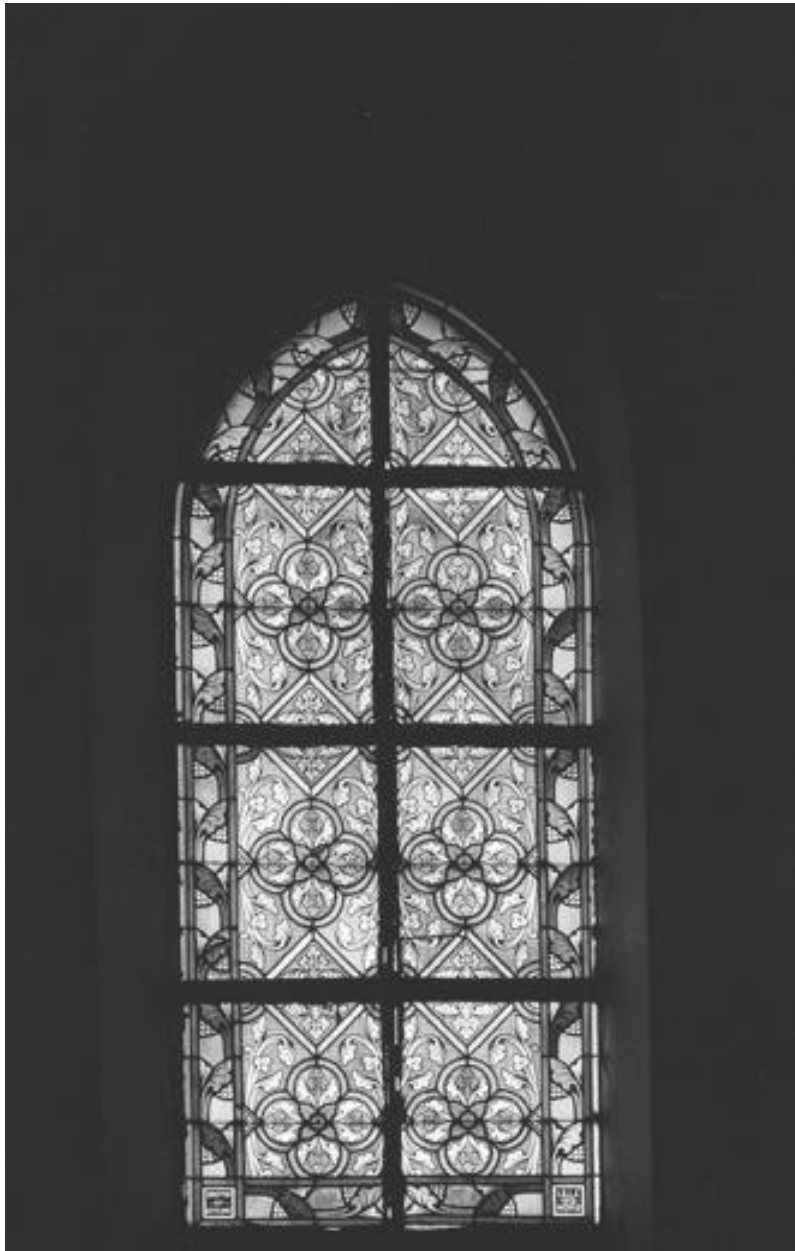
Verrière de la nef, mur nord.
