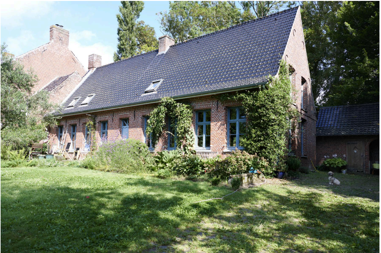
Façade principale sud et pignon est.
