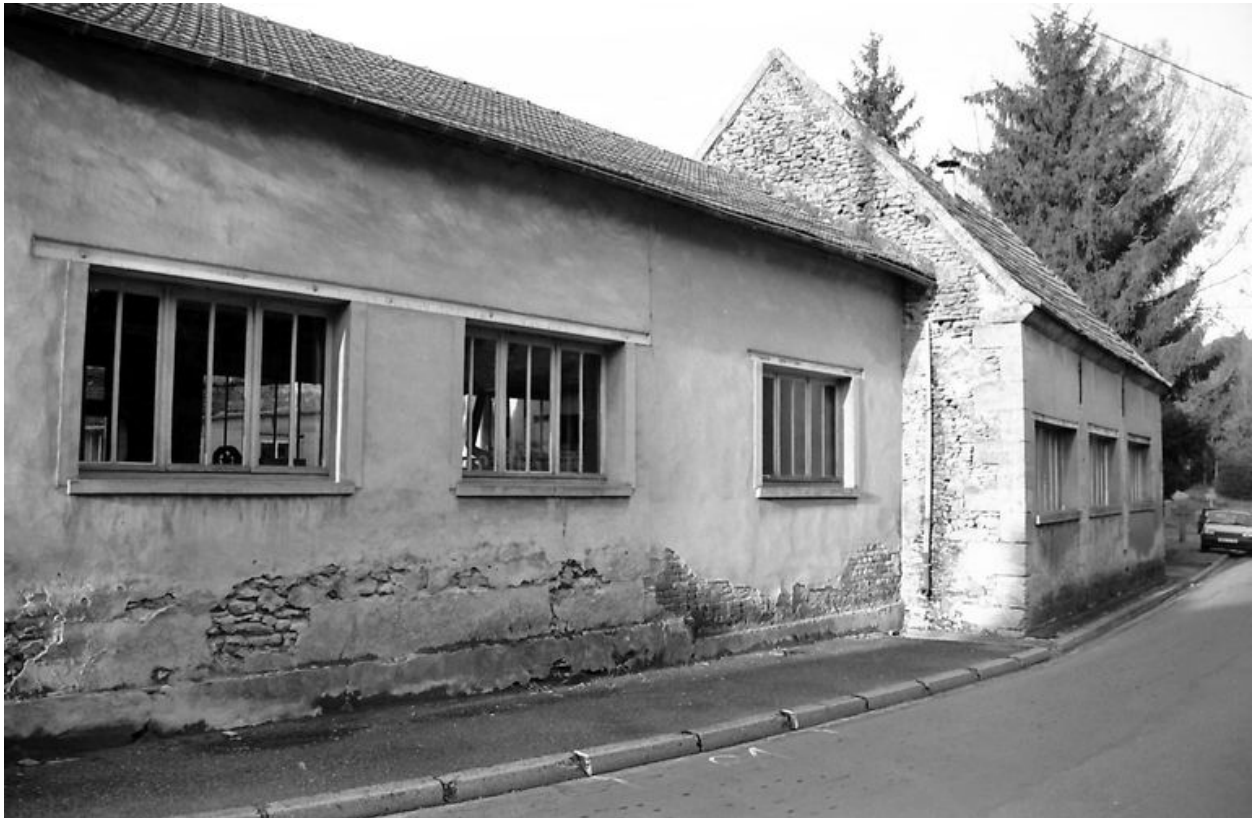
Atelier de fabrication, façade sur rue.
