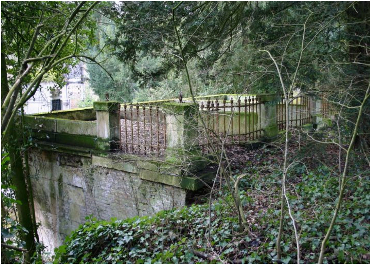
Vue du toit-terrasse.
