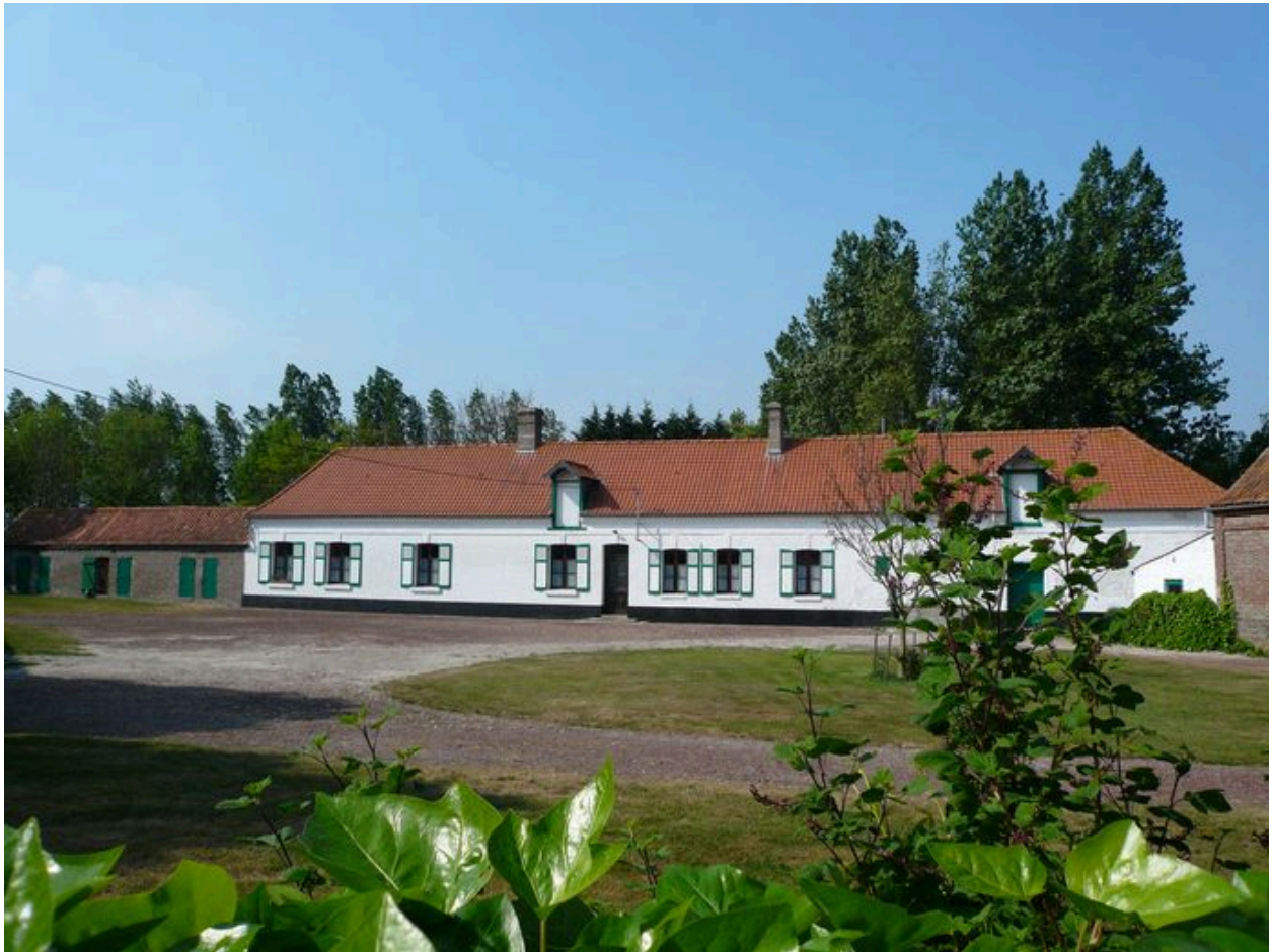
Vue du logis, flanqué à l'est des écuries et à l'ouest, des porcheries.
