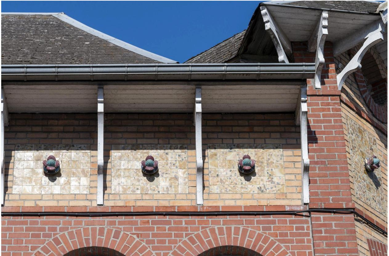
Détail de la toiture débordante et des décors du bandeau d'attique : aisseliers, calepinage de briques, carreaux de faïence, cabochons en terre cuite émaillée.
