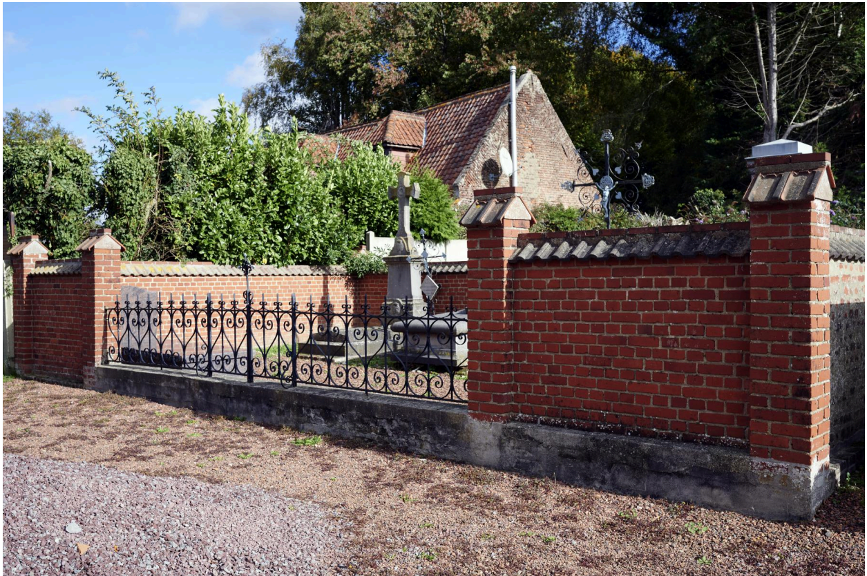
Vue générale de l'enclos funéraire.
