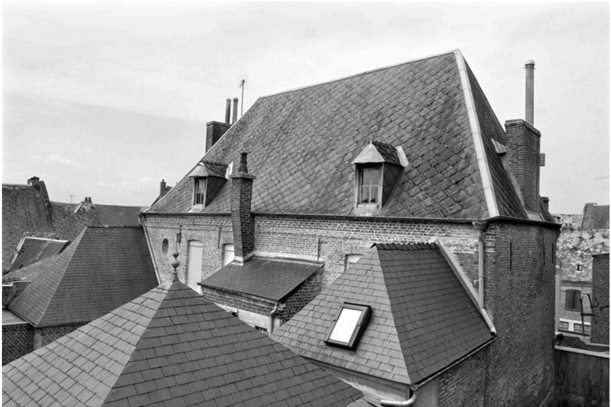
Vue de l'élévation postérieure, depuis une maison située place de l'église.
