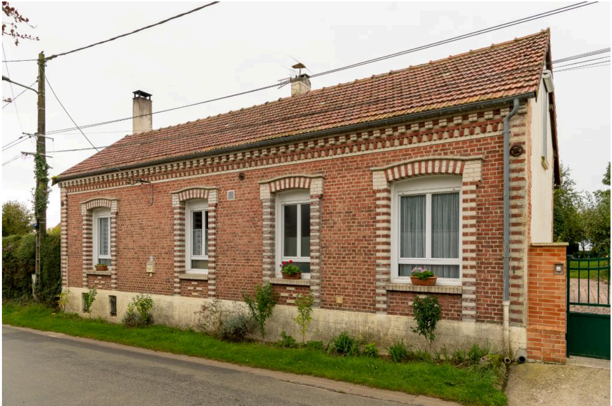
Maison n°32 rue du Pressoir, vue depuis le nord.
