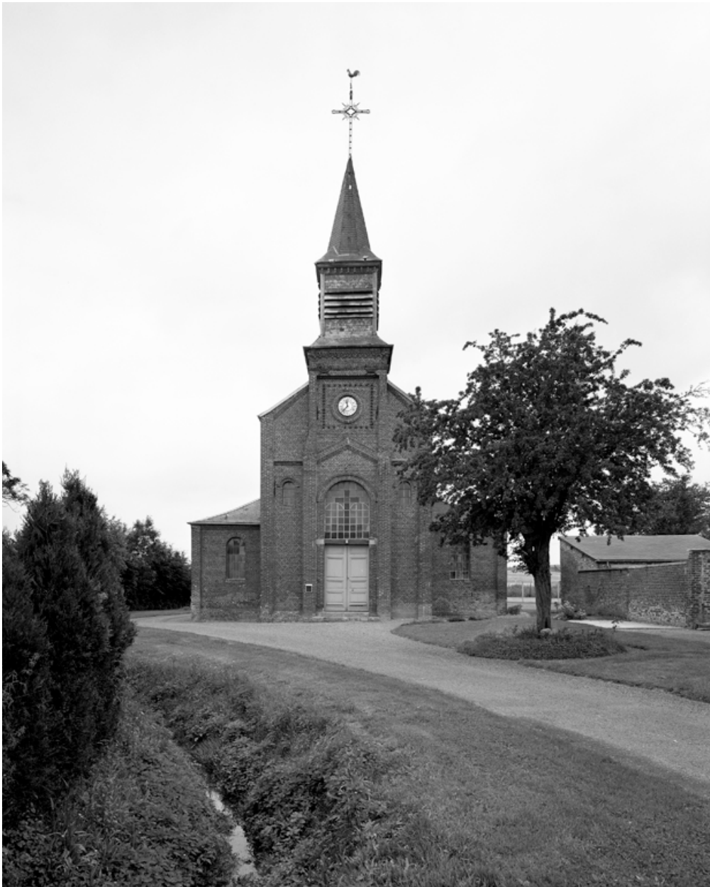
Vue générale de la façade.
