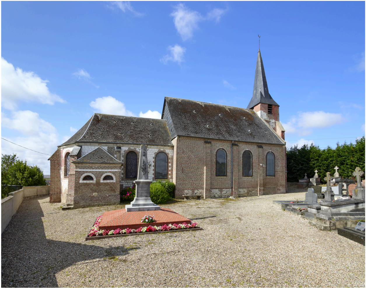
Vue d'ensemble de l'église, depuis le nord.
