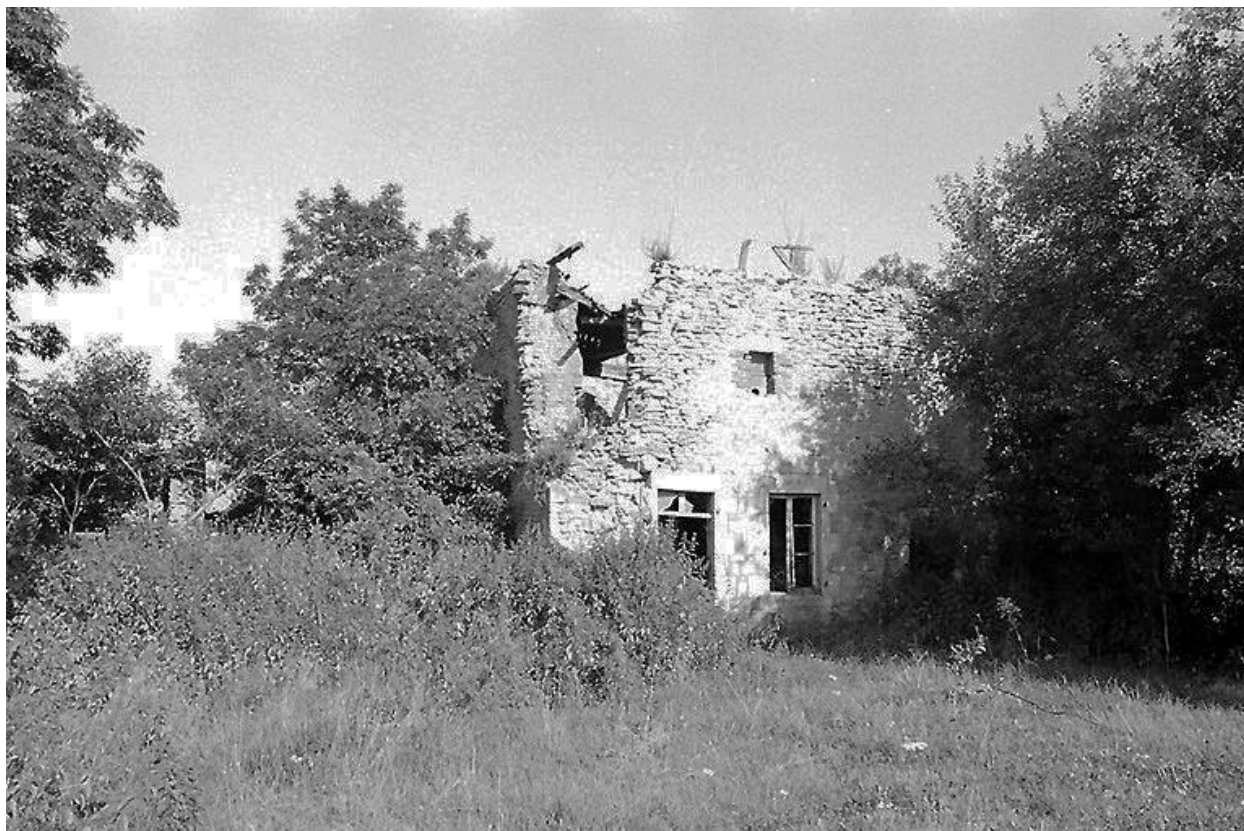
Vue du logis ruiné, avec sur la gauche, les vestiges de l'échauguette circulaire.
