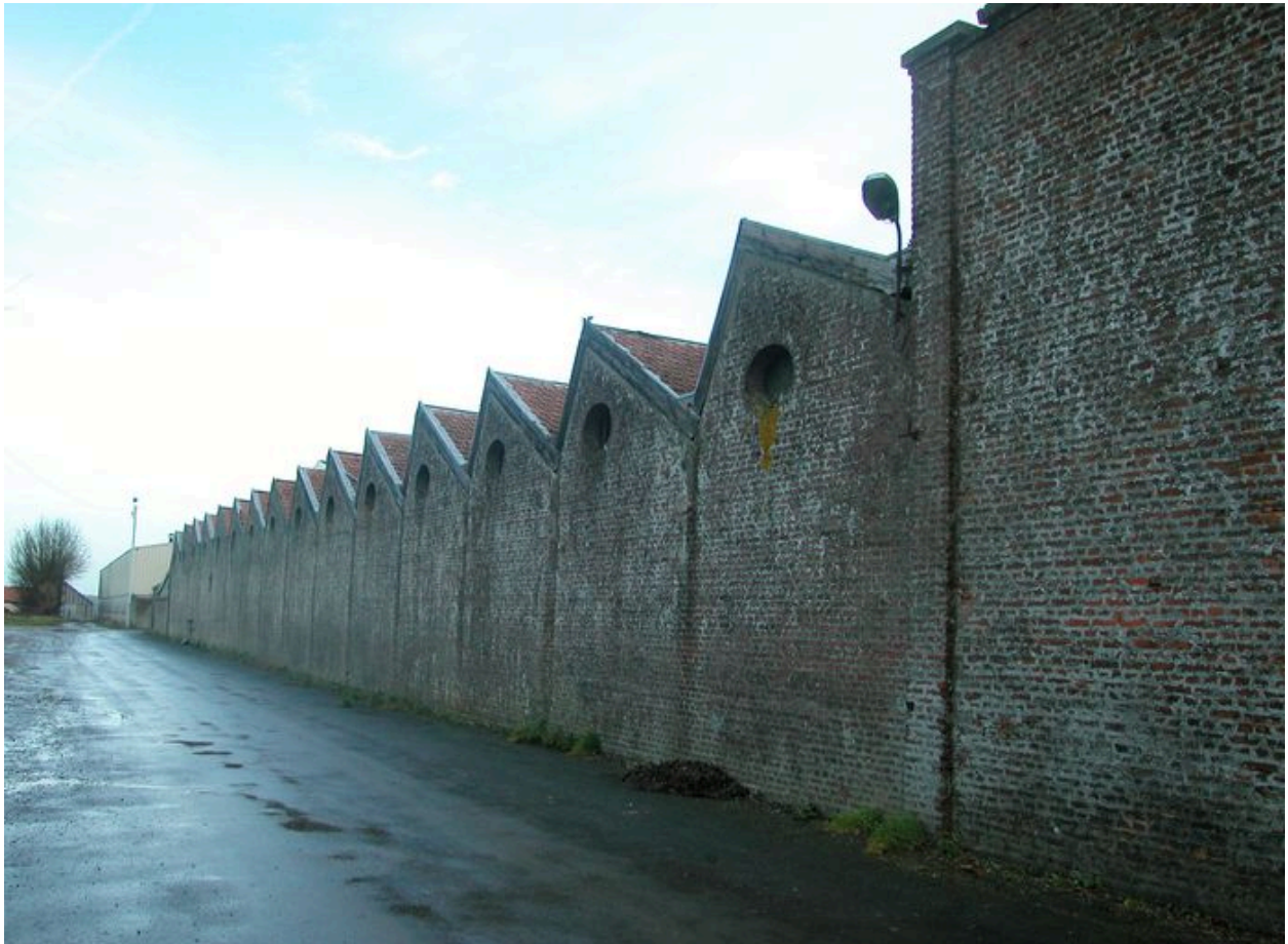
Façade sur rue des ateliers de fabrication.
