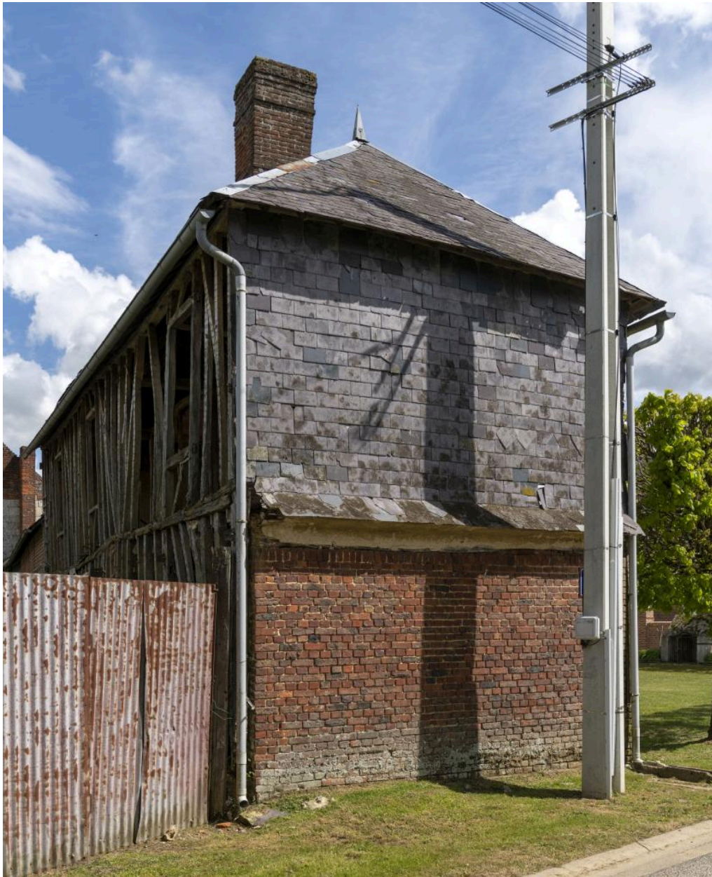
Pignon avec essentage en ardoise, n°37 Grande Rue, vue depuis l'ouest.
