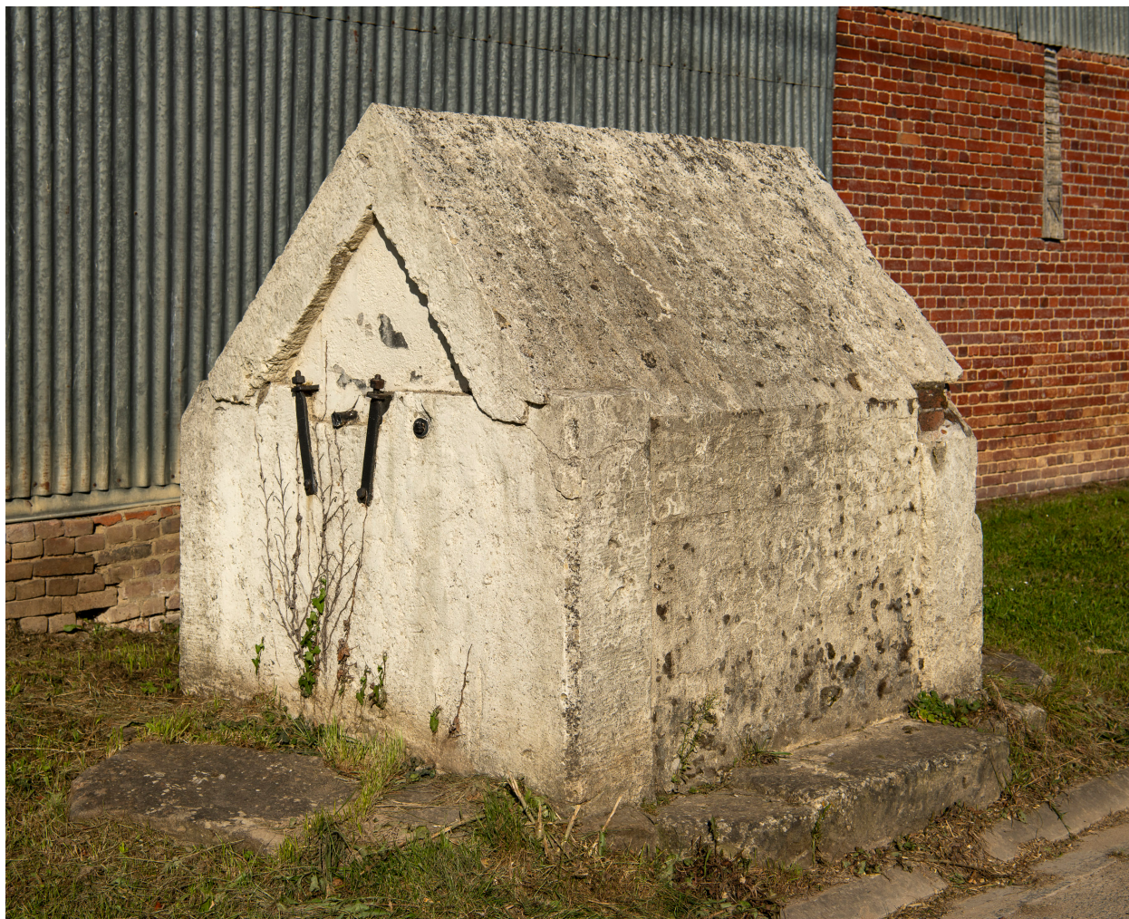
Ancien puits, rue de Plainville.
