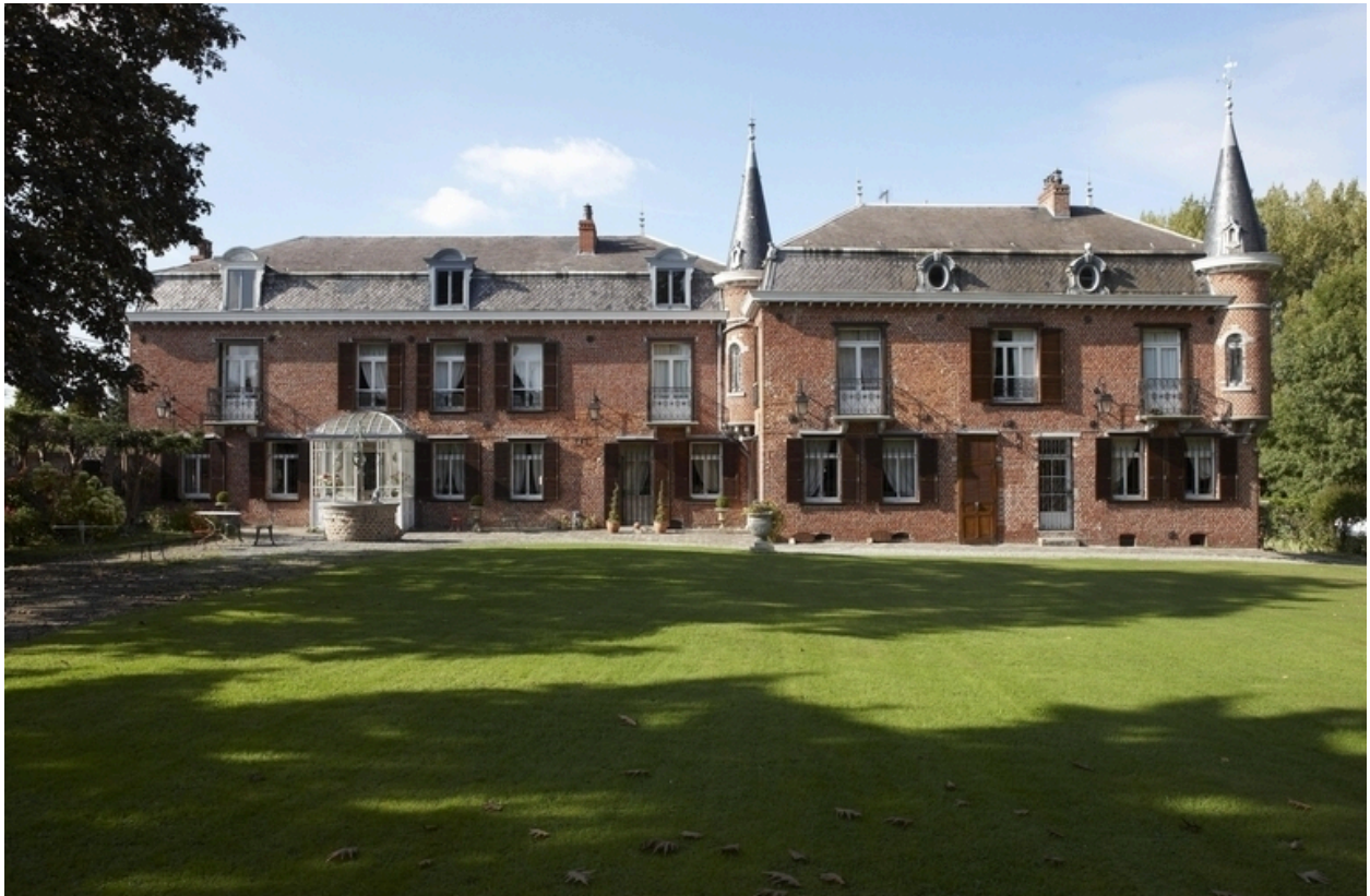
Vue générale depuis le parc.
