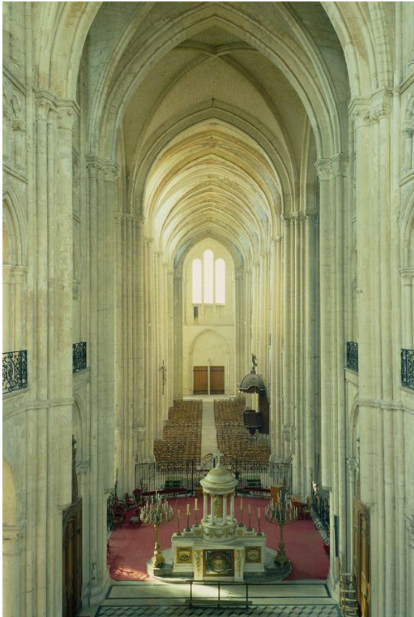
Vue intérieure de la nef, d'est en ouest.
