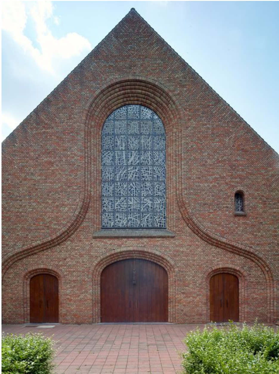
Élévation antérieure de l'église.
