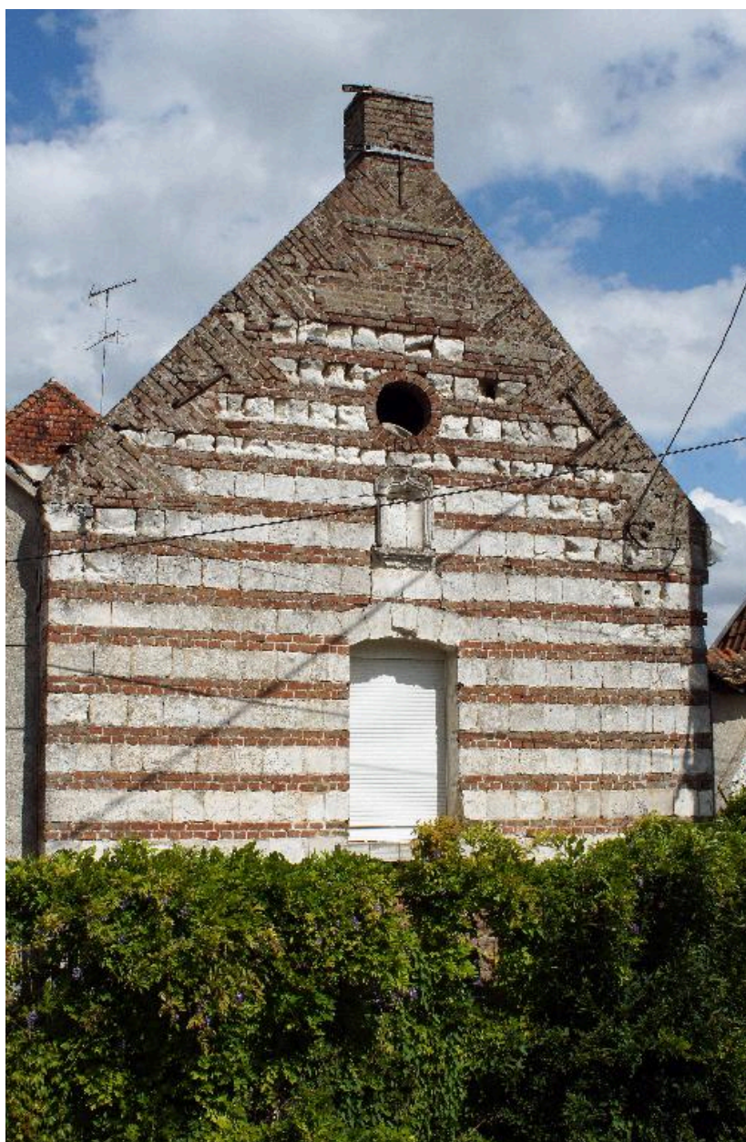
Vue du pignon à assises alternées brique et pierre.
