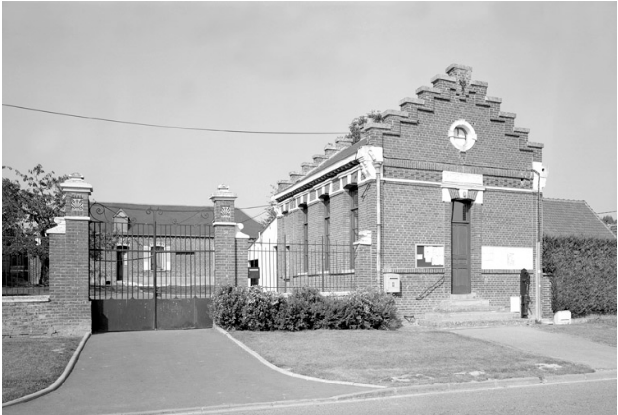
Vue du bâtiment oriental.
