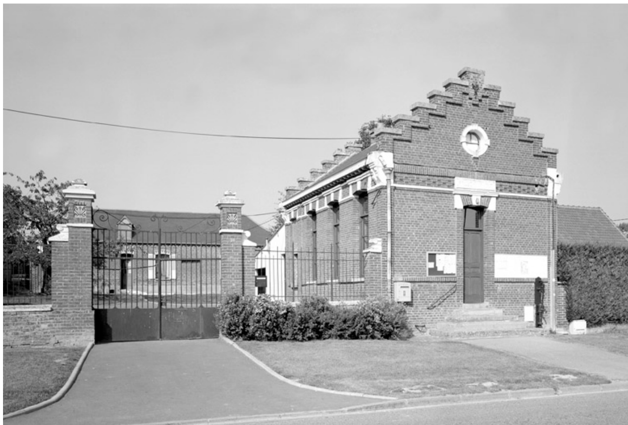
Vue du bâtiment oriental.
