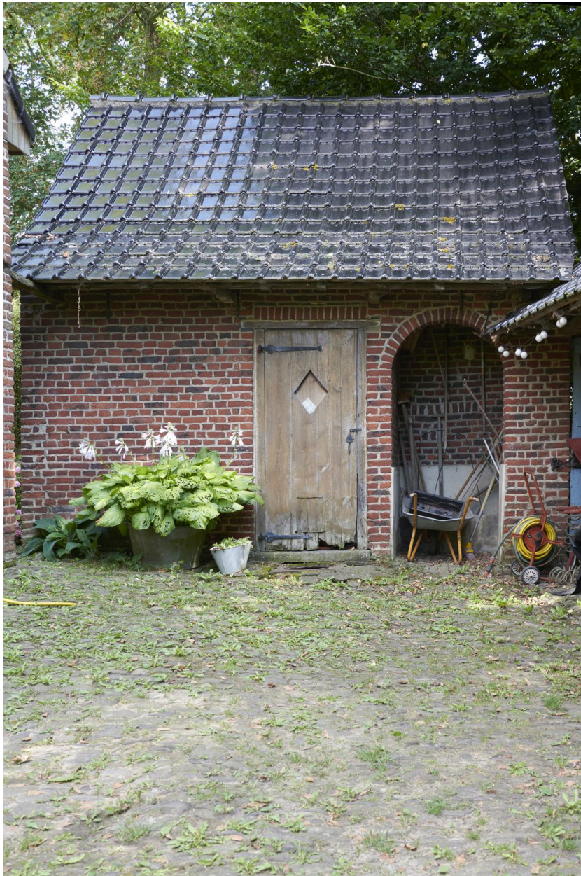
Ancien lavoir, façade sud et cour pavée.
