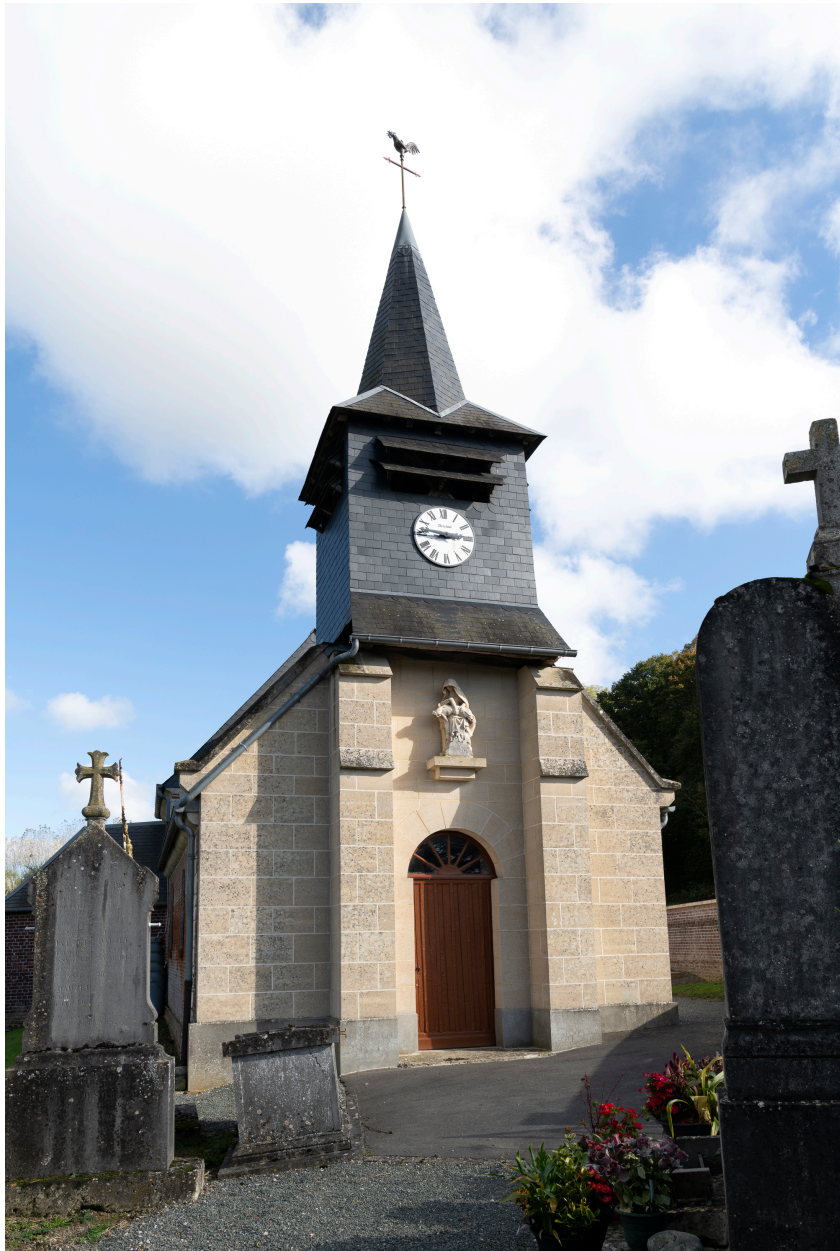
Vue générale de la façade occidentale.
