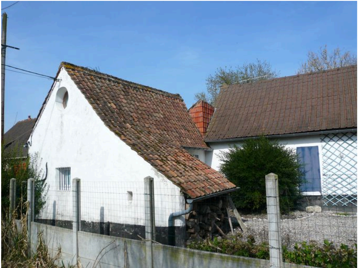
Vue du bâtiment à l'ouest.
