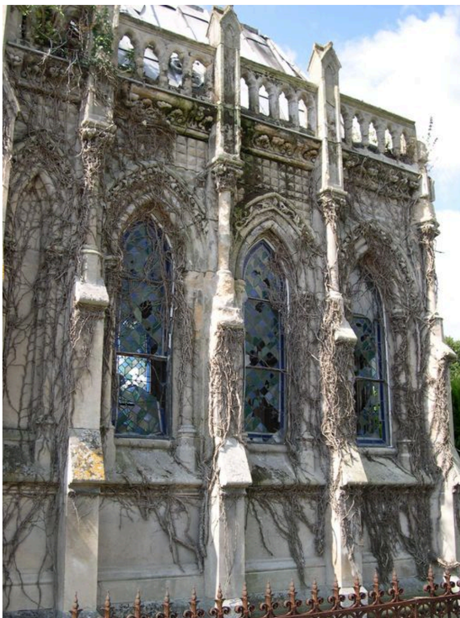
Vue du mur nord.
