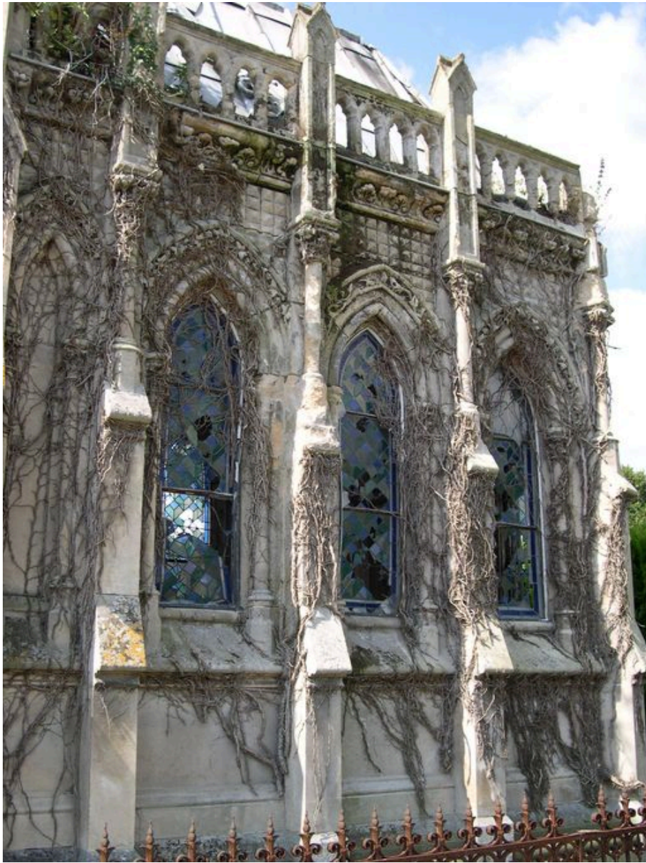
Vue du mur nord.
