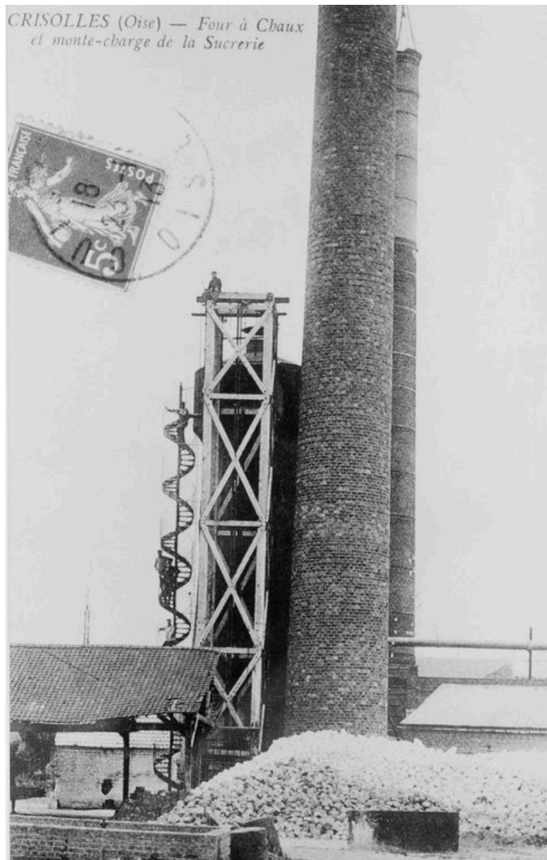
Le four à chaux avec son monte-charge, avant 1914 (AC Crisolles).
