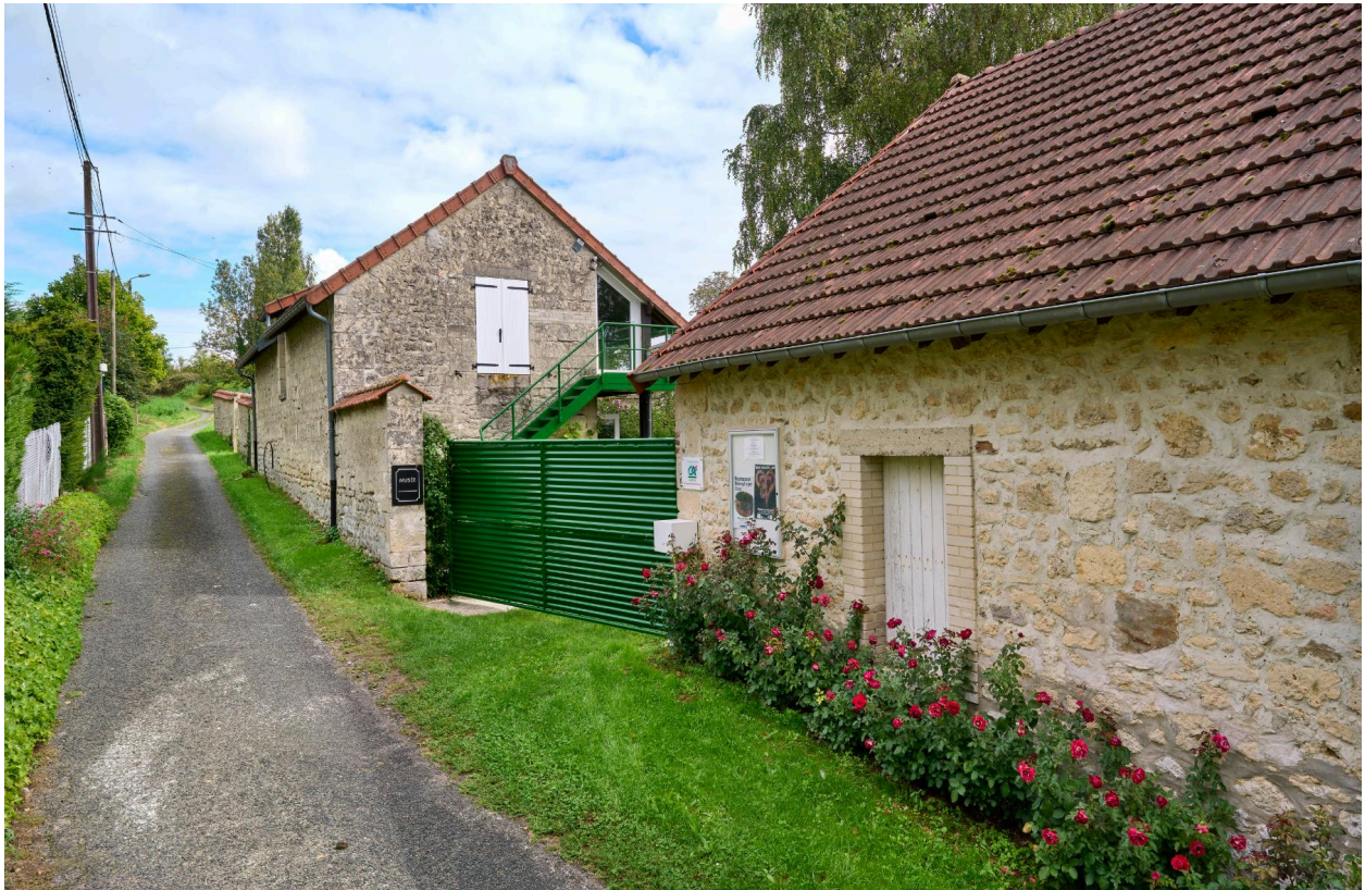
Accès à la cour de l'atelier, vue nord portail fermé.
