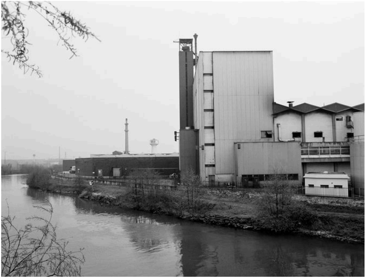
Ateliers de fabrication, vue partielle.
