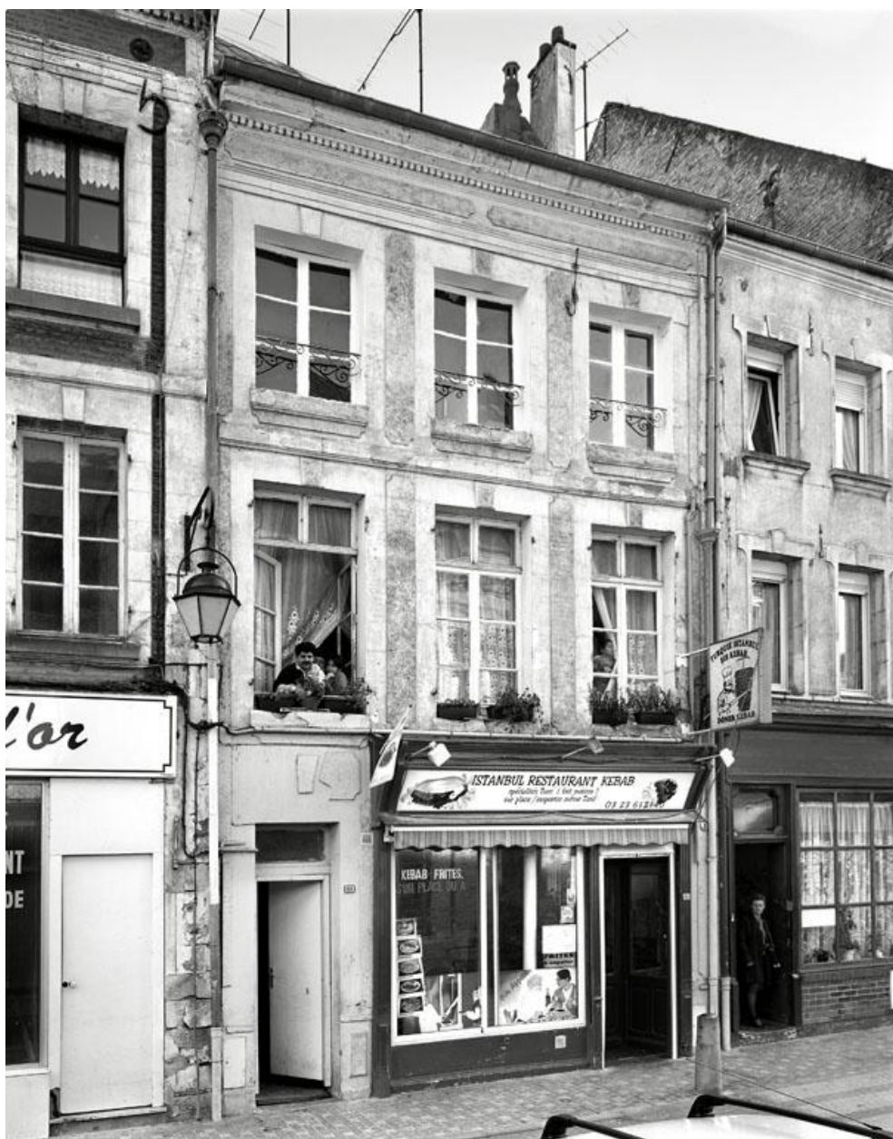
Vue de la façade sur rue.
