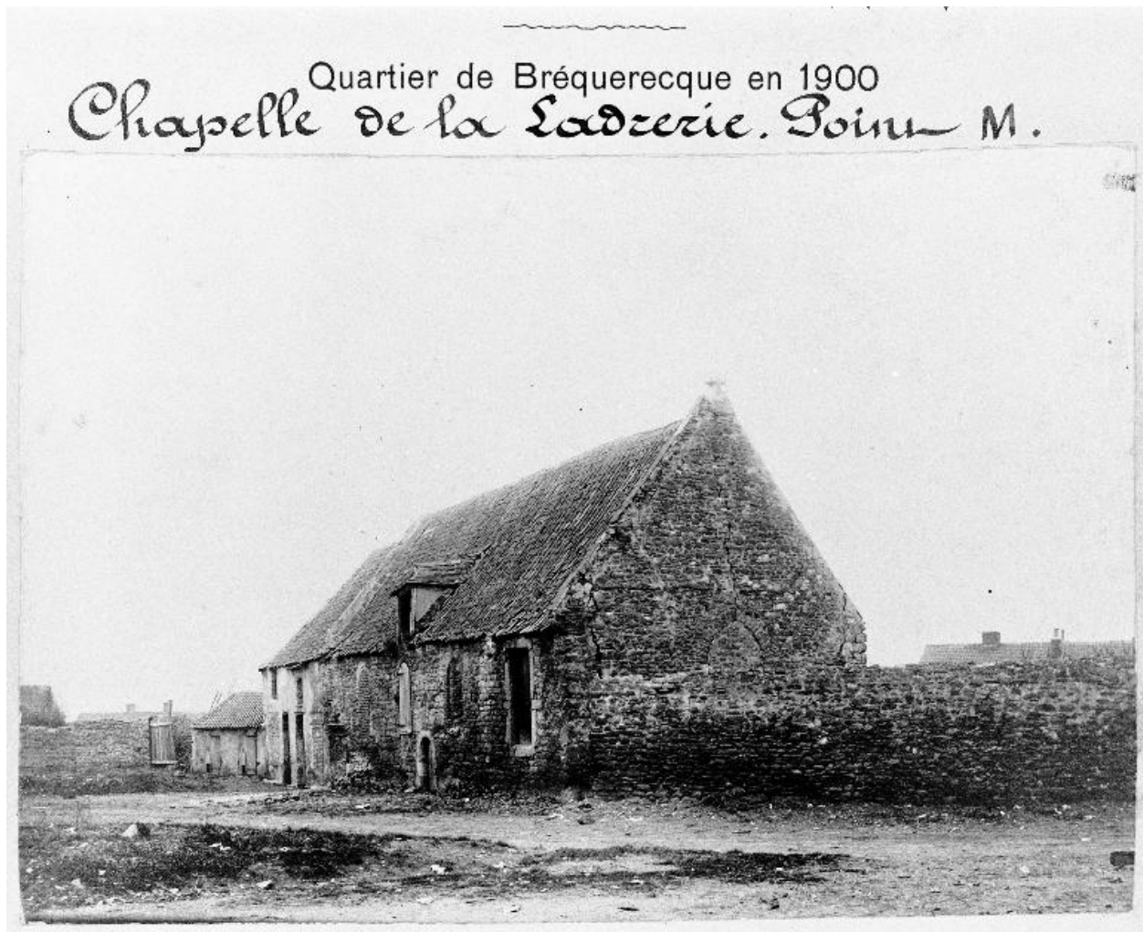
Chapelle, façade d'angle sur cour, état en 1900 (AC Boulogne-sur-Mer).
