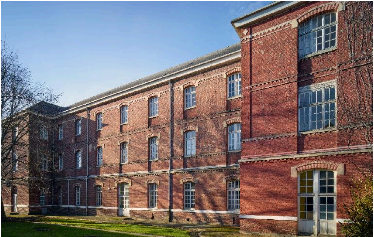
Bâtiment de malades dit pavillon 6, élévation antérieure donnant sur le jardin, vue générale prise de trois quarts droit.
