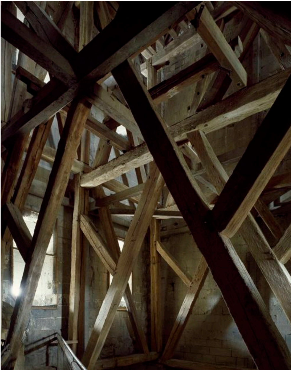
Vue de la charpente du clocher.
