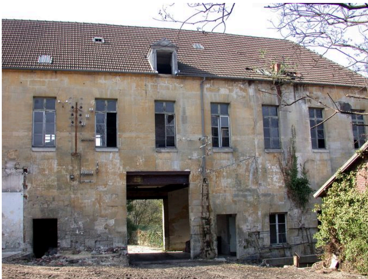
La filature, façade ouest.
