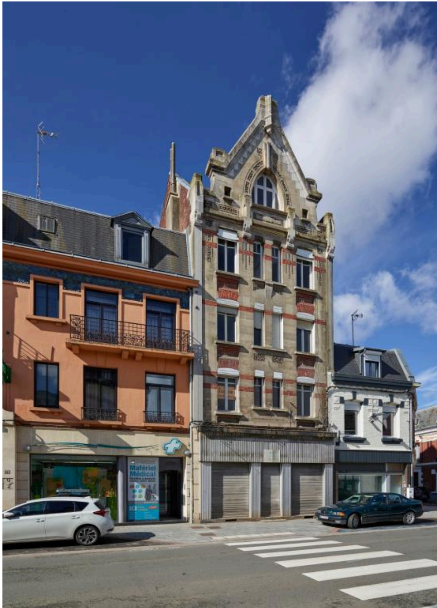
Vue générale de la façade principale depuis la rue de Péronne.
