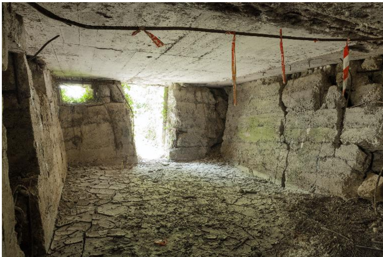
Vue intérieure vers la sortie sud
