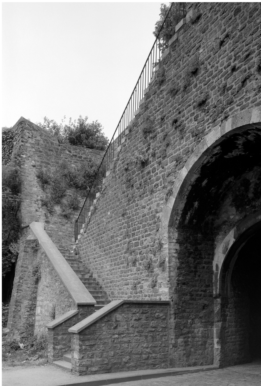
Vue de profil sur escalier.
