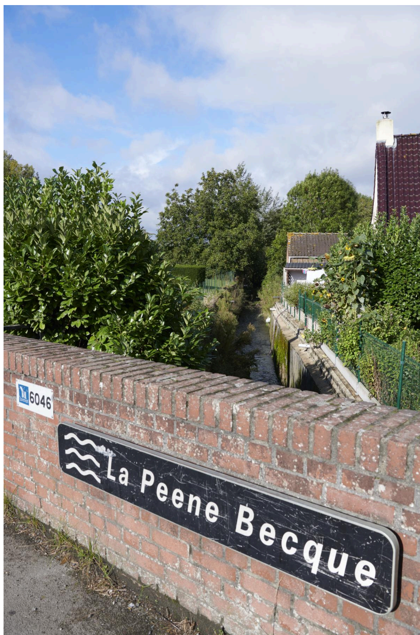
Pont de la Peene Becque qui traverse le village.
