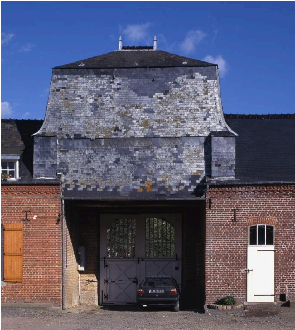
Le pavillon d'entrée de la ferme, vu depuis la cour.
