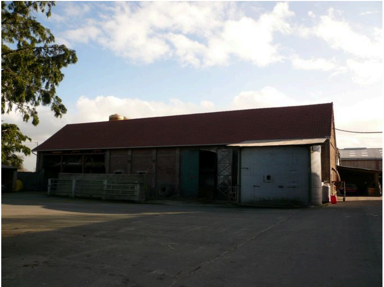
Vue de la grange au sud.
