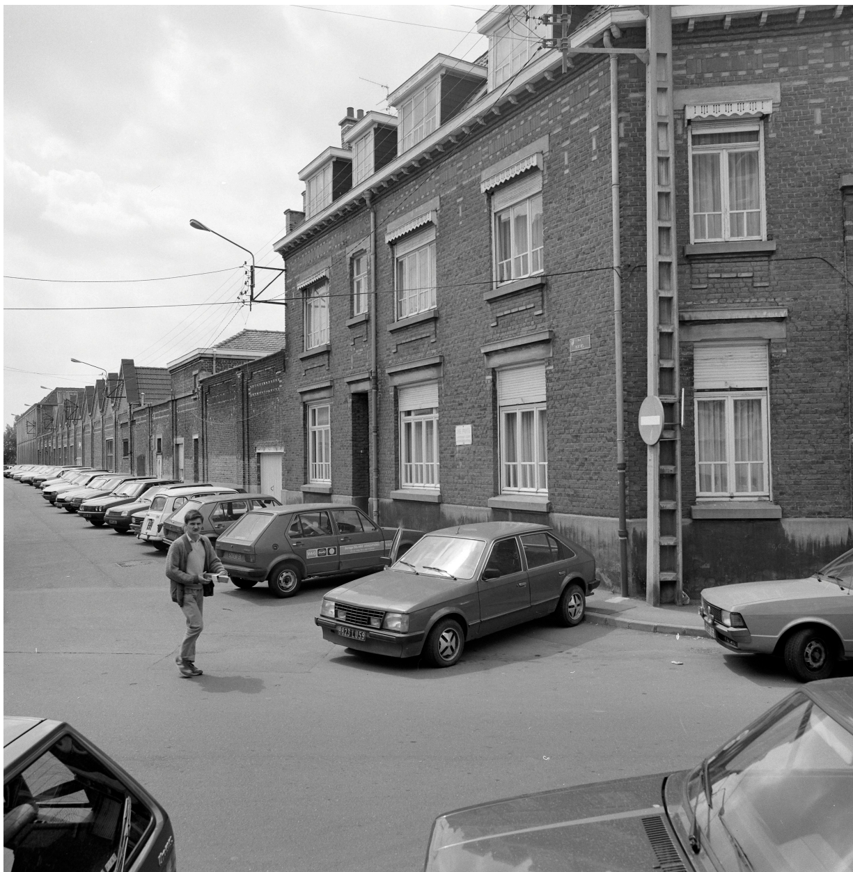
Élévation rue Hurtel. Vue générale prise vers le sud.
