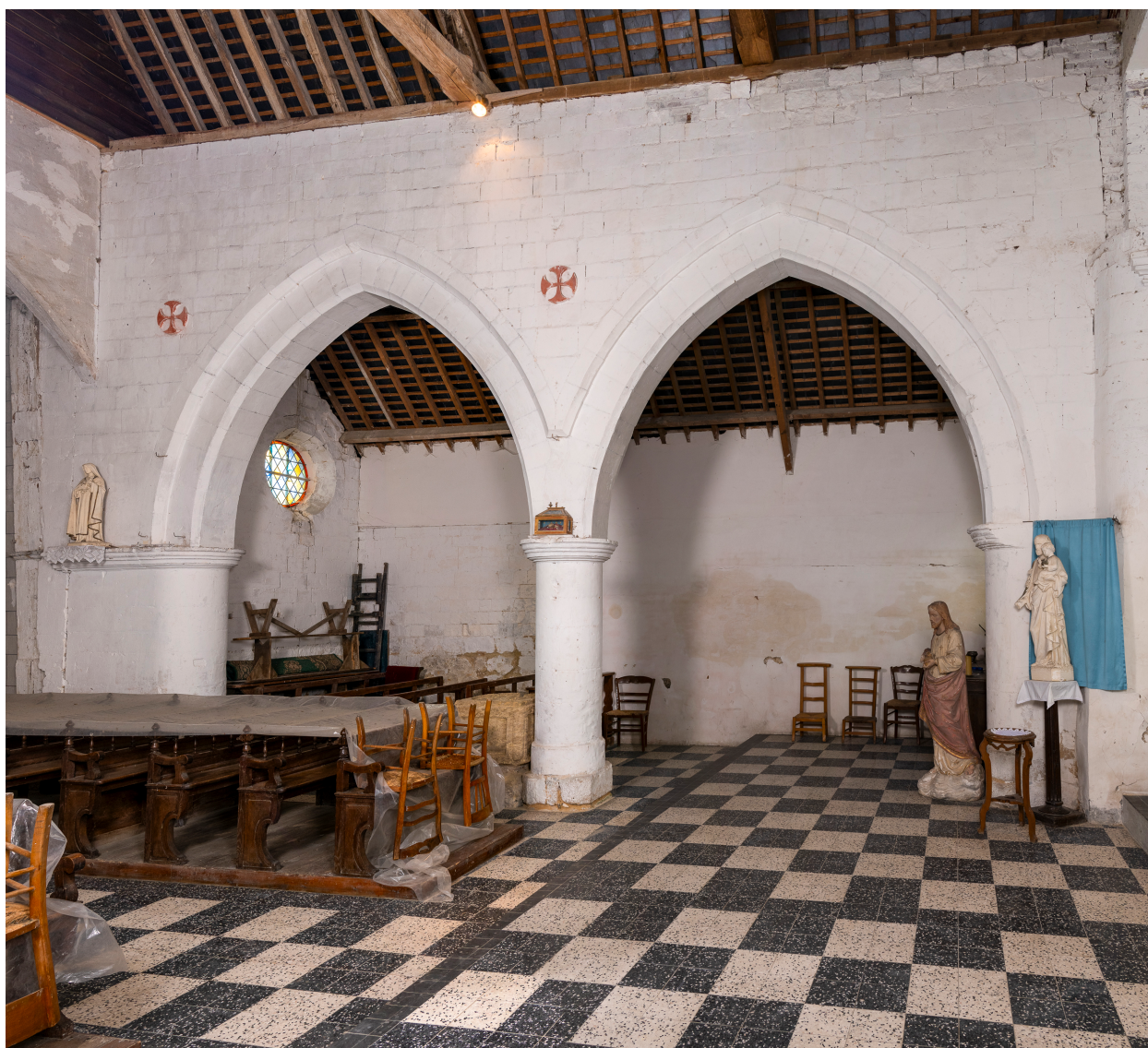
Vue intérieure vers la chapelle nord.
