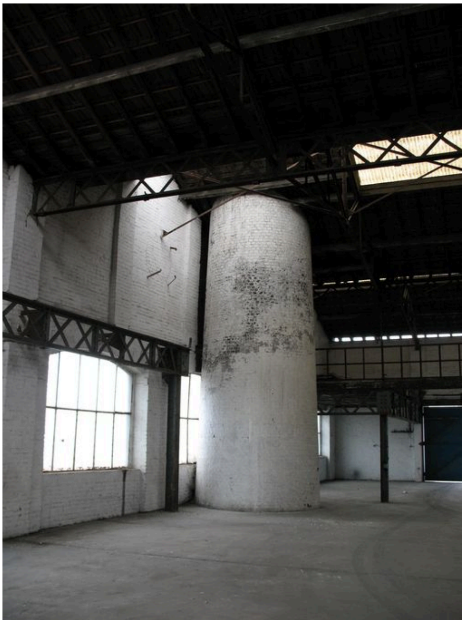
Partie tronconique de la cheminée au premier étage de l'usine.
