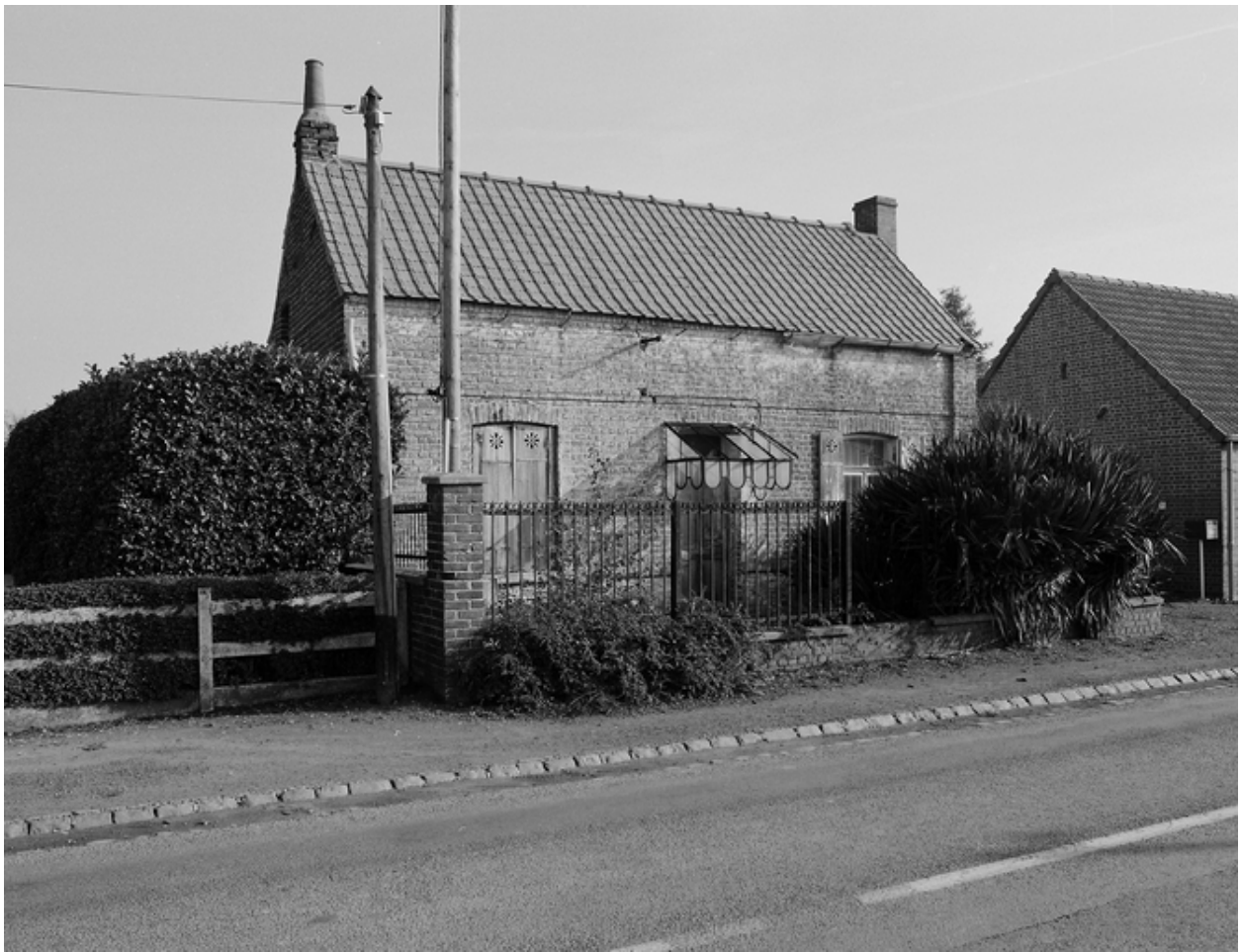
Maison élémentaire, 1059, rue de Lelier.
