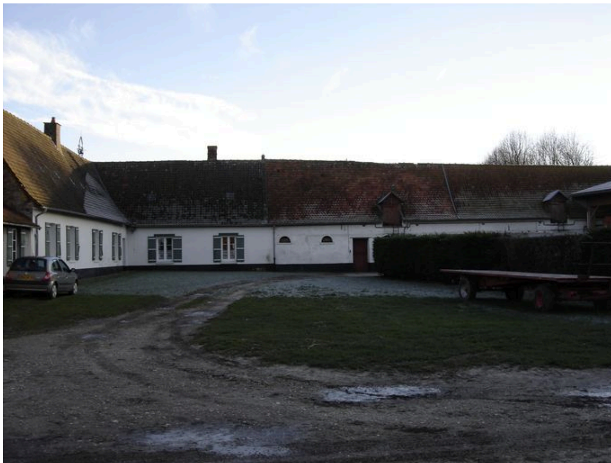
Vue des étables situées au sud de la cour.
