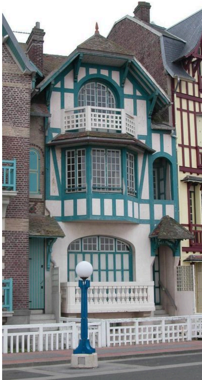
Vue d'ensemble, façade sur mer.
